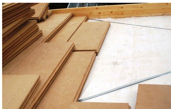
Foto 4, 5) Klázení desek ve třech vrstvách na sebe (desky Hofatex UD, 3x100 = 300 mm), spoje všech desek „na vazbu“. Diagonální vyztužení střechy v tomto případě ztužuje pultovou střechu v rovině střechy
