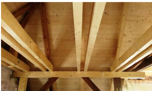
Foto 10, 11) Pohled z půdy na krokve s ponecháním původních nepoškozených prvků
