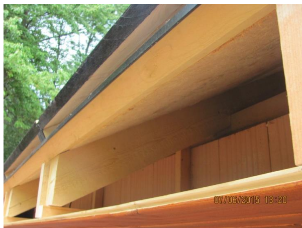
Foto 1) Dřevěný hranol podél okapu vytvoří rovnou linii a oporu pro položení první řady desek
