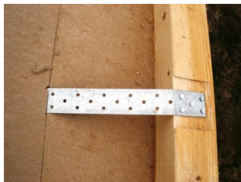
Foto 2, 3) Celoobvodový střešní rám na pultové střeše, připevnění pomocí zavětrovacích pásek do krokví
