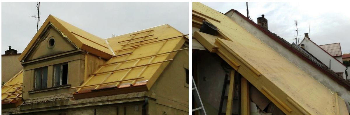
Foto 14, 15) Zateplená část střechy směrem do ulice. Detail v řezu, zřetelné jsou dvě desky tl. 120 mm položené na sobě
