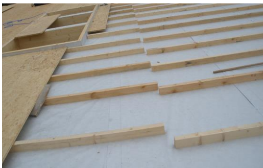
Foto 6, 7) Uložení kontralatí, šroubování samořeznými stavebními vruty RAPI-TEC HBS, 460 mm
