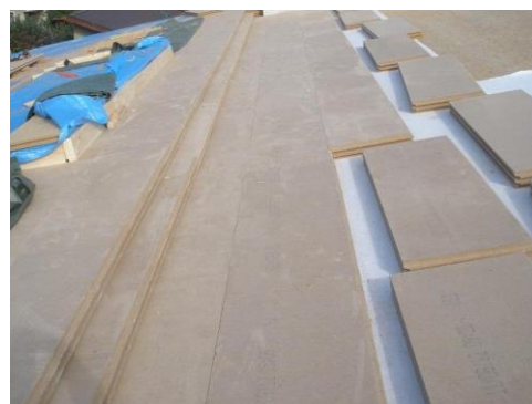
Foto 4, 5) Klázení desek ve třech vrstvách na sebe (desky Hofatex UD, 3x100 = 300 mm), spoje všech desek „na vazbu“. Diagonální vyztužení střechy v tomto případě ztužuje pultovou střechu v rovině střechy
