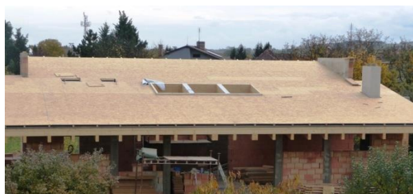
Foto 6, 7) Uložení kontralatí, šroubování samořeznými stavebními vruty RAPI-TEC HBS, 460 mm
