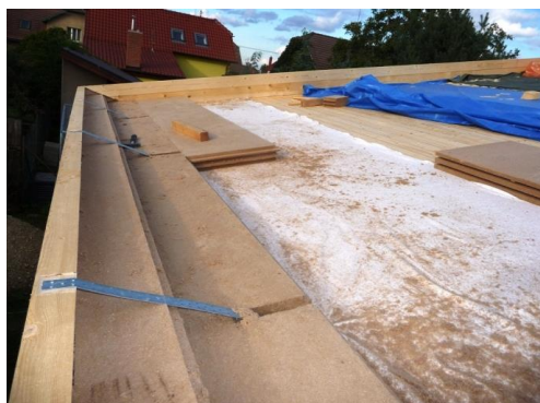
Foto 2, 3) Celoobvodový střešní rám na pultové střeše, připevnění pomocí zavětrovacích pásek do krokví
