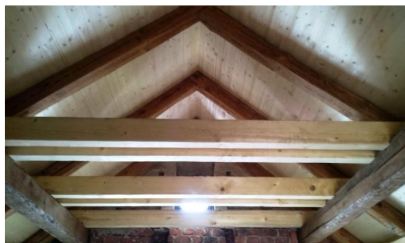
Foto 10, 11) Pohled z půdy na krokve s ponecháním původních nepoškozených prvků
