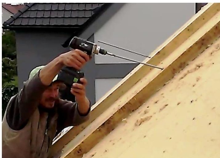
Foto 12, 13) Staveništní příprava vrutů Twin UD 440 mm do kontralatí a jejich šroubování na střeše
