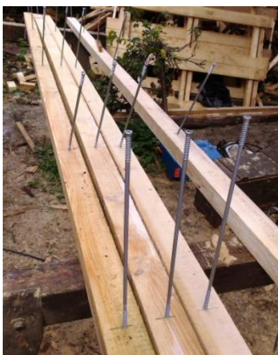
Foto 12, 13) Staveništní příprava vrutů Twin UD 440 mm do kontralatí a jejich šroubování na střeše
