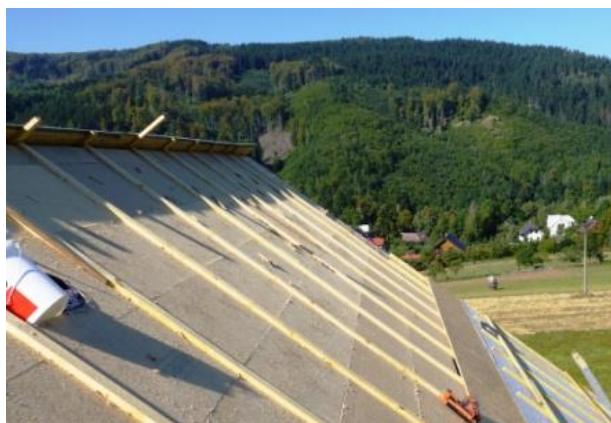
Obr. 11) Plošné zakrytí sedlové střechy
