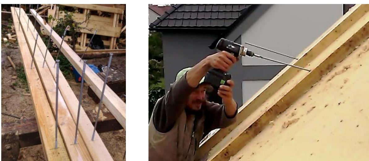
Foto 4, 5) Stavění půdorysu vrutů Twin UD 440 mm do kontralatí a jejich šroubování na střeše
