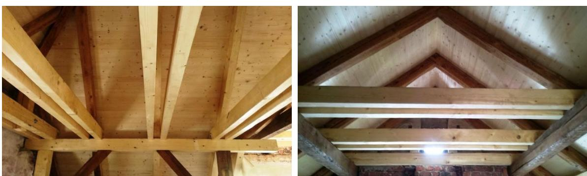
Foto 2, 3) Pohled z půdy na krokve s ponecháním původních nepoškozených prvků
