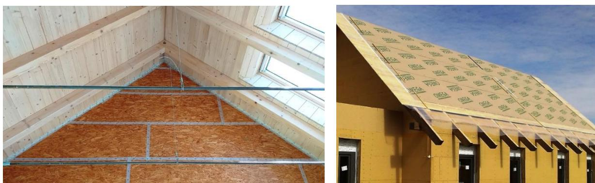
**Foto 8, 9)** Interiér a palubkový záklop s parobrzdou vzduchotěsnou fólií Isocel
