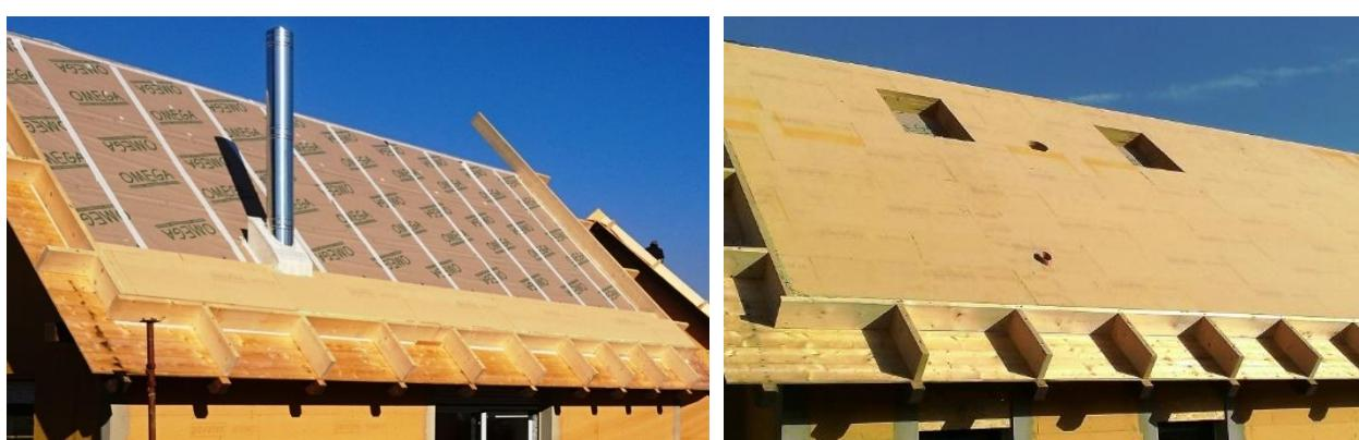
**Foto 10, 10)** Dřevovláknité desky ISOLAIR 2 x 120 = 240 mm
