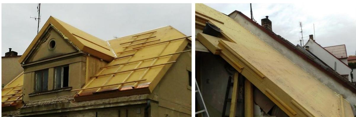
**Foto 6, 7)** Zateplená část střechy směrem do ulice. Detail v řezu, zřetelné jsou dvě desky tl. 120 mm položené na sobě
