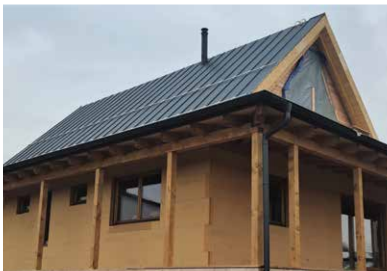
Obr. 10 - Střecha po dokončení, obvodová stěna čeká na dřevěný obklad
