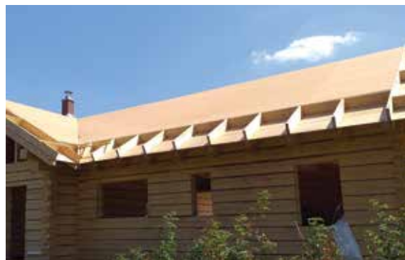
Obr. 4 - Souvislá plocha z desek Pavatex
