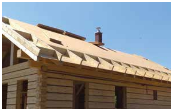
Obr. 5 - Plocha z desek Pavatex před dokončením u hřebene
