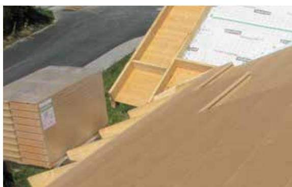
Obr. 6 - Vymezená plocha pro Pavatex nad vytápěným podkrovím
