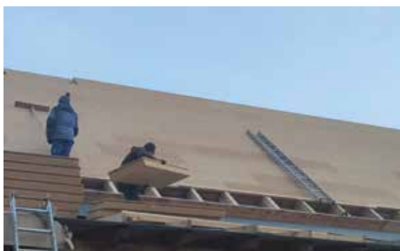
Obr. 9 - Pokládání desek Pavatex
