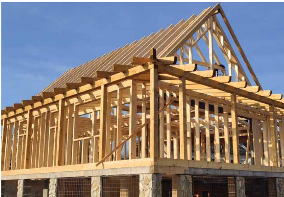
Obr. 7 - Nosná kostra dřevostavby
