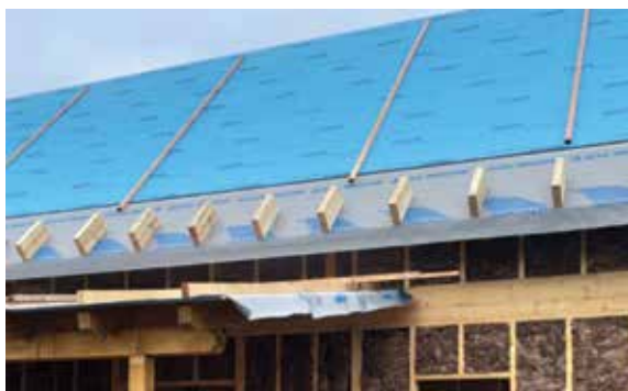
Obr. 8 - Parobrzdná vzduchotěsná membrána Pavatex DSB 2 na střeše, obvodová stěna Diffuwall 2010 v přízemí
