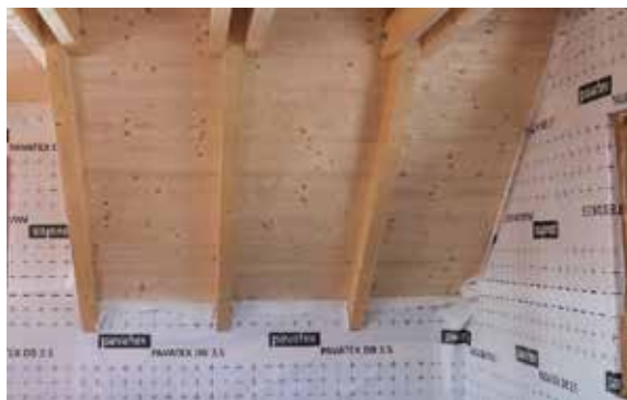
Obr. 3 - Difúzně otevřená štítová a podélná stěna podkroví
