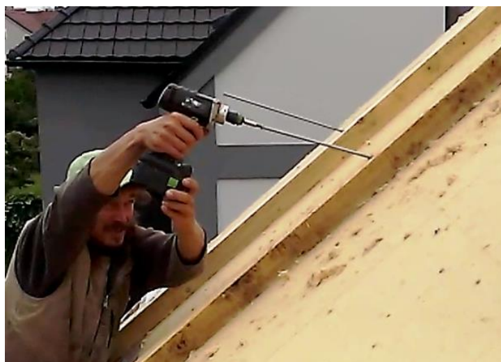
Foto 2, 3) Staveništní příprava vrutů Twin UD 440 mm do kontralatí a jejich šroubování na střeše
