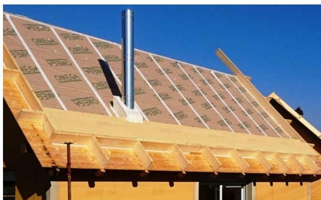
Foto 8, 9) Dřevovláknité desky ISOLAIR 2 x 120 = 240 mm
