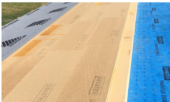
Foto 10, 11) Dřevovláknité desky PAVATHERM 120 mm + ISOLAIR 100 = 220 mm. Vzduchotěsná parobrzdná fólie PAVATEX DSB 2
