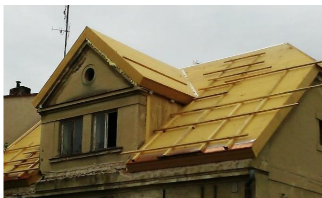
Foto 4, 5) Zateplená část střechy směrem do ulice. Detail v řezu, zřetelné jsou dvě desky tl. 120 mm položené na sobě
