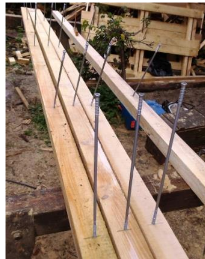
Obr. 3): schéma uspořádání šikmých vrutů Twin UD
