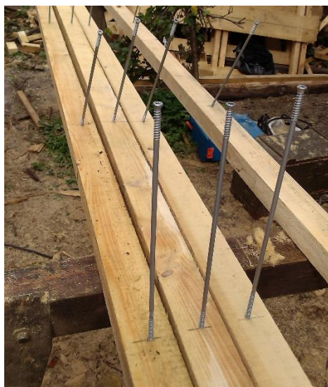
Foto 2, 3) Staveništní příprava vrutů Twin UD 440 mm do kontralatí a jejich šroubování na střeše
