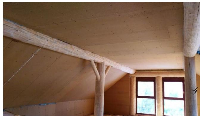
Obr. 6A, 6B : Laťový rošt vyplňovaný tepelnou izolací, souvislá plocha desek Pavatex připravená k povrchové úpravě
